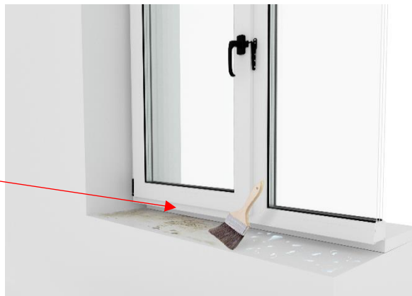
Рис. 7.1. Очищення поверхні.
