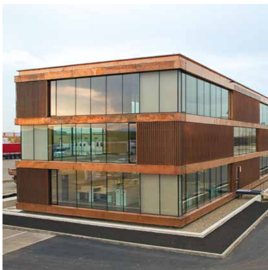
Budynek biurowy firmy EGGER w Radauti (RO) otrzymał Złoty Certyfikat DGNB za zrównoważony projekt i wydajność energetyczną. Według tego schematu wybudowane zostały także TechCenter w Unterradlbergu (AT), Forum w Brilonie (DE) i nowy budynek administracyjny w St. Johann (AT).
